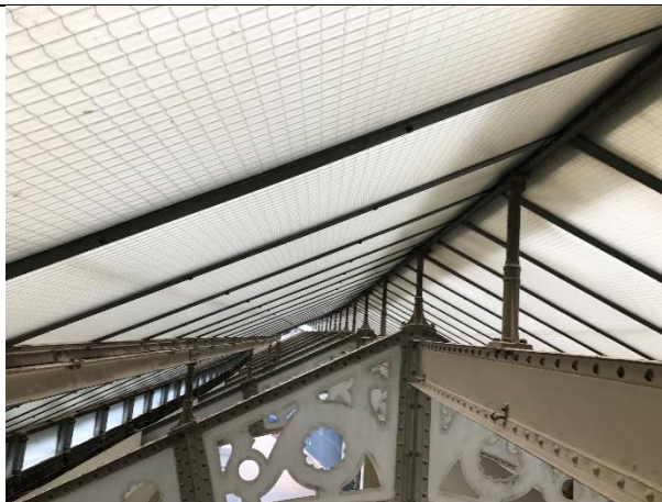
Photo 4 : vue de la panne faîtière et d'une panne courante
