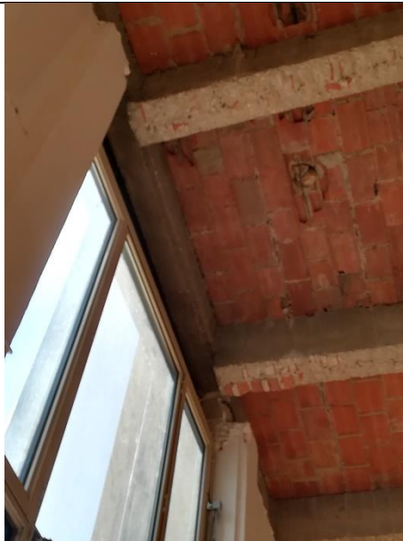
Photo 2 : vue des poutres support de plancher
